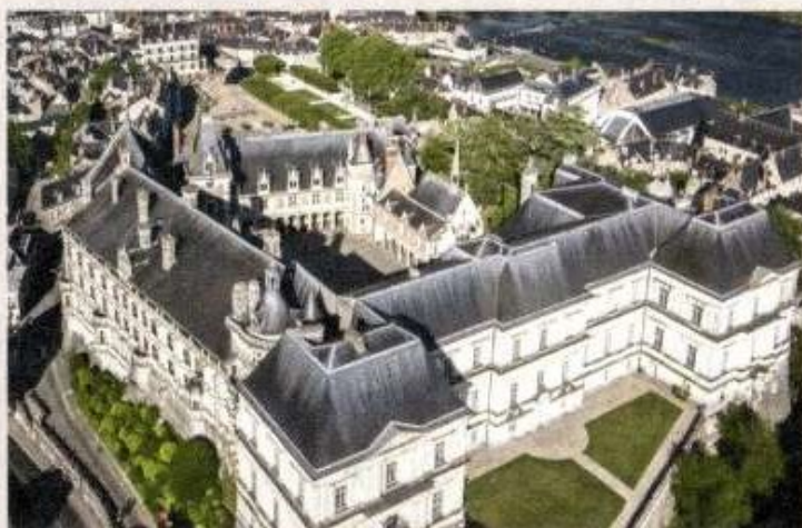
Vue aérienne du château royal de Blois
